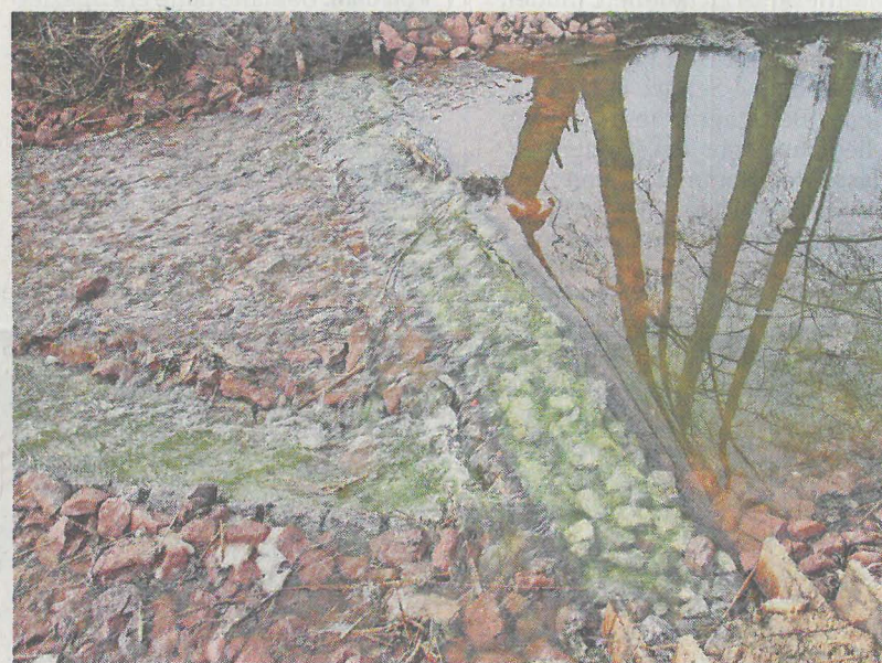
Eine sogenannte Sohlgleite aus Steinen und Holz ersetzt das alte Wehr und soll verhindern, dass der Wasserstand zu stark fällt. FOTO: CHRISTIN SCHMIDT
